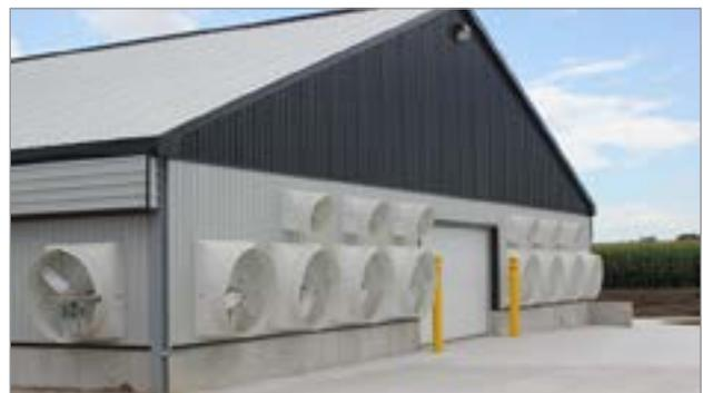
**Figure 2.** Ventilateurs d'extraction installés dans le mur d'extrémité opposé aux prises d'air.
