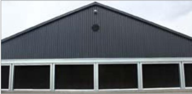
**Figure 3.** Tapis humides installés sur les prises d'air dans un système de ventilation longitudinale avec refroidissement par évaporation.
