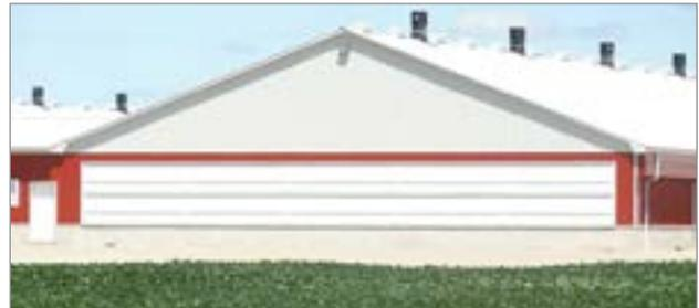
**Figure 1.** Trappes servant de prises d'air sur toute la longueur du mur d'extrémité d'un bâtiment d'élevage soumis à la ventilation longitudinale, sans refroidissement par évaporation.
