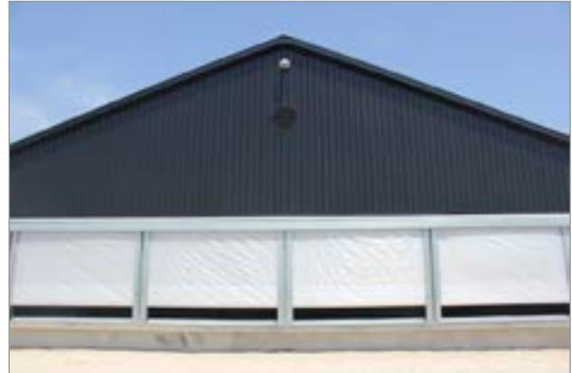
**Figure 11.** Tapis humides du système de refroidissement par évaporation, partiellement recouverts d'une bâche blanche protectrice.
