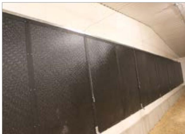
**Figure 10.** Portes isolées fermées cachant les tapis humides servant au refroidissement par évaporation.
