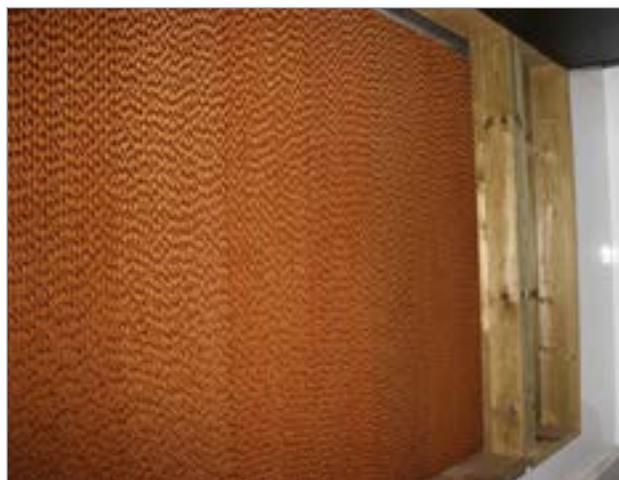
**Figure 9.** Surface intérieure du tapis humide lorsque la porte isolée est ouverte.
