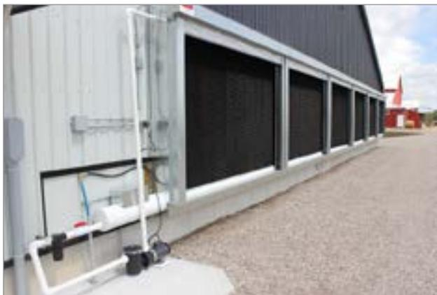
**Figure 7.** Pompe de circulation, tapis humide, tuyau d'alimentation en eau fraîche (tuyau bleu) et filtre d'un système de refroidissement par évaporation.
